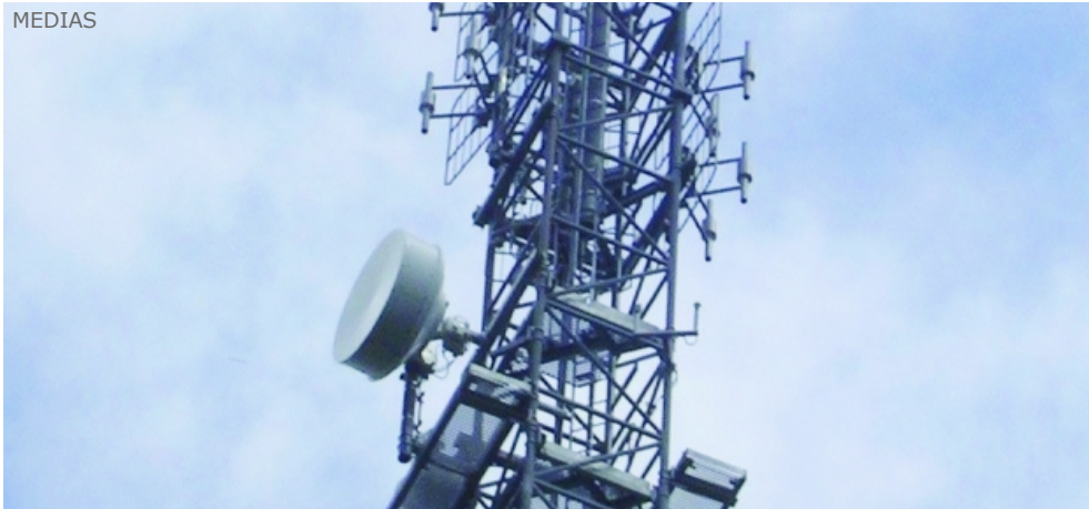
Un émetteur radio-TV au Val-de-Travers: pour la bande FM, la télévision numérique et le DAB+. SP
